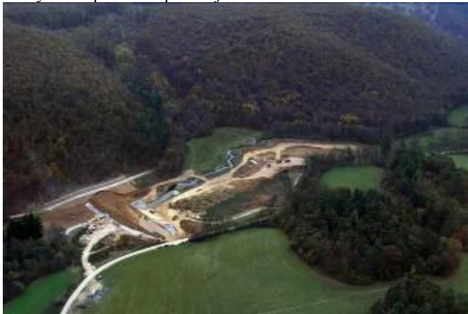
Obr. Letecký záber na stavbu poldra
